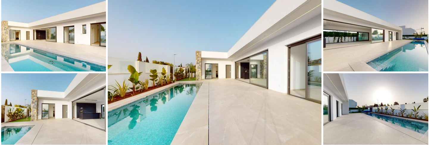
New build villas in los alcazares
