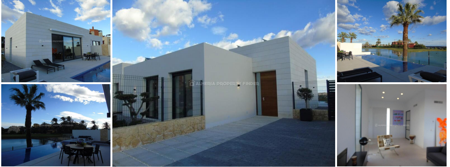
Las Villas Valle Del Este - A villa in the Vera area. (Off Plan)
