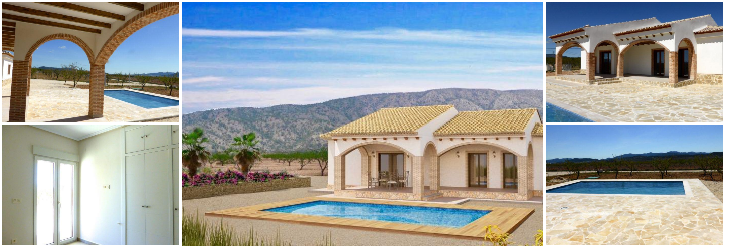
VILLA I TYPISK SPANSK BYG
