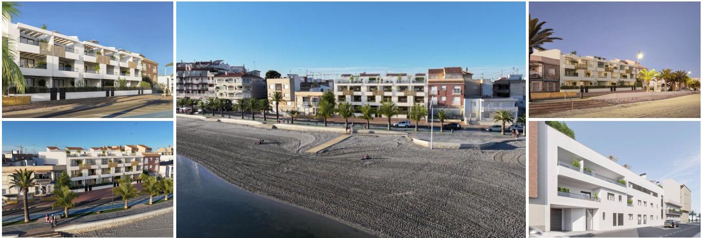
NIEUWBOUW VILLA IN SAN PEDRO DEL PINATAR
