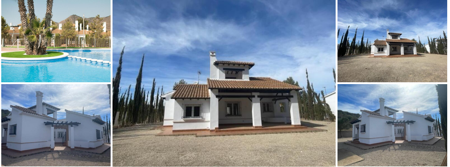
KEY READY VILLA IN FUENTE ALAMO, MURCIA
