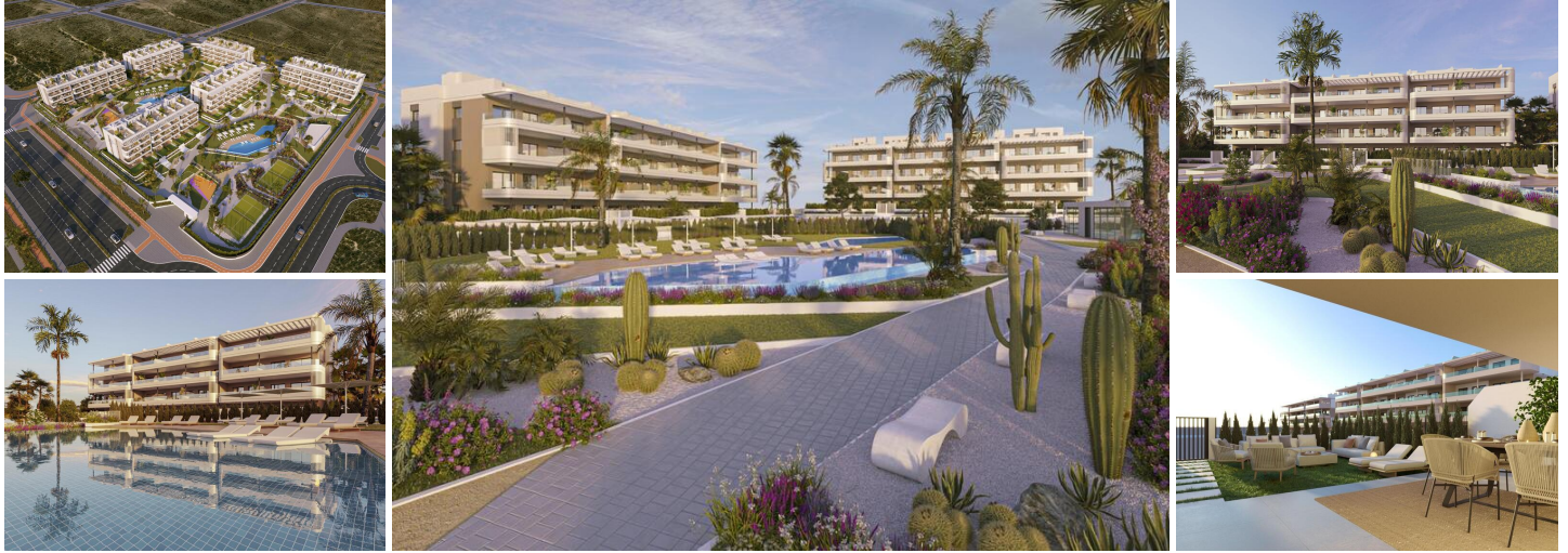
Moderne nieuwbouwappartementen in La Hoya, Torrevieja
