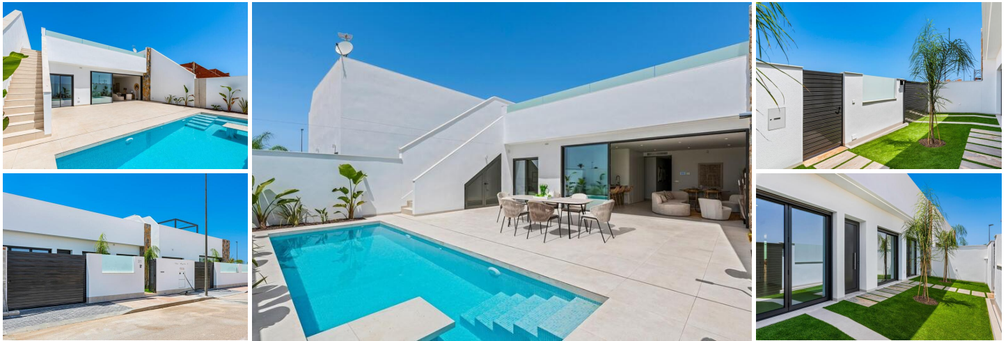
Nieuwbouw stadswoningen in los alcazares
