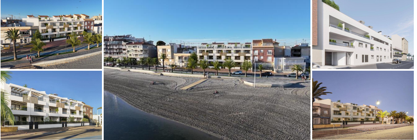
Nieuwbouw villa in san pedro del pinatar
