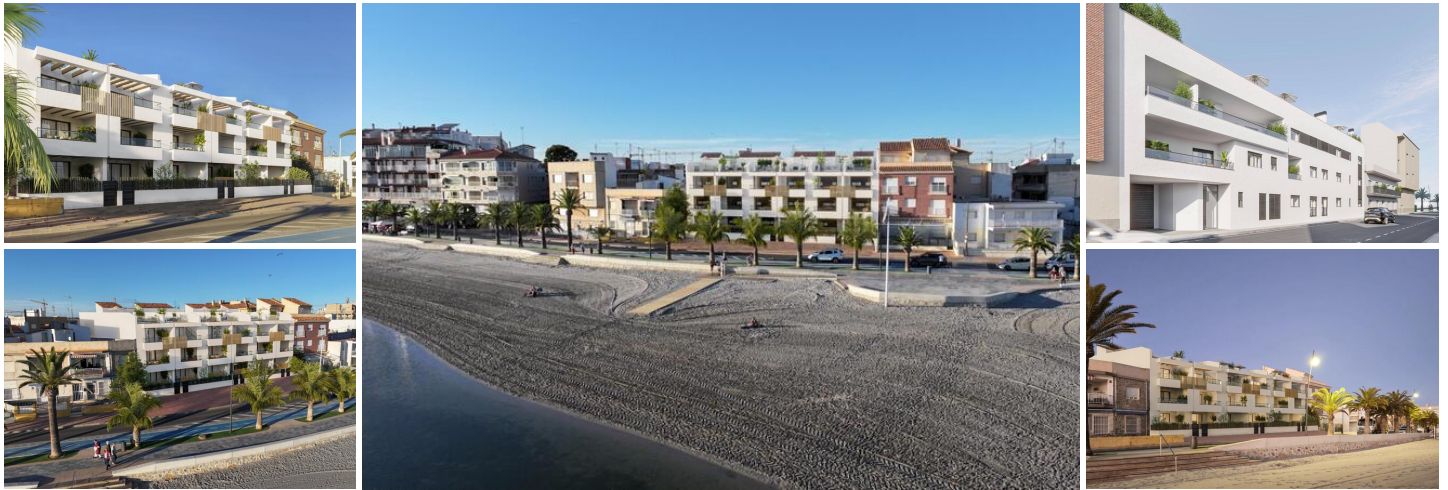
Nieuwbouw villa in san pedro del pinatar
