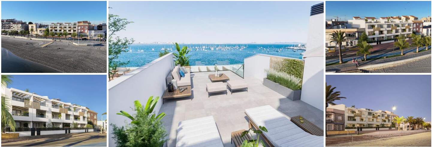
Nieuwbouw villa in san pedro del pinatar
