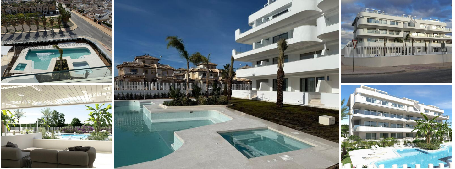
Nieuwbouw wooncomplex in lomas de cabo roig
