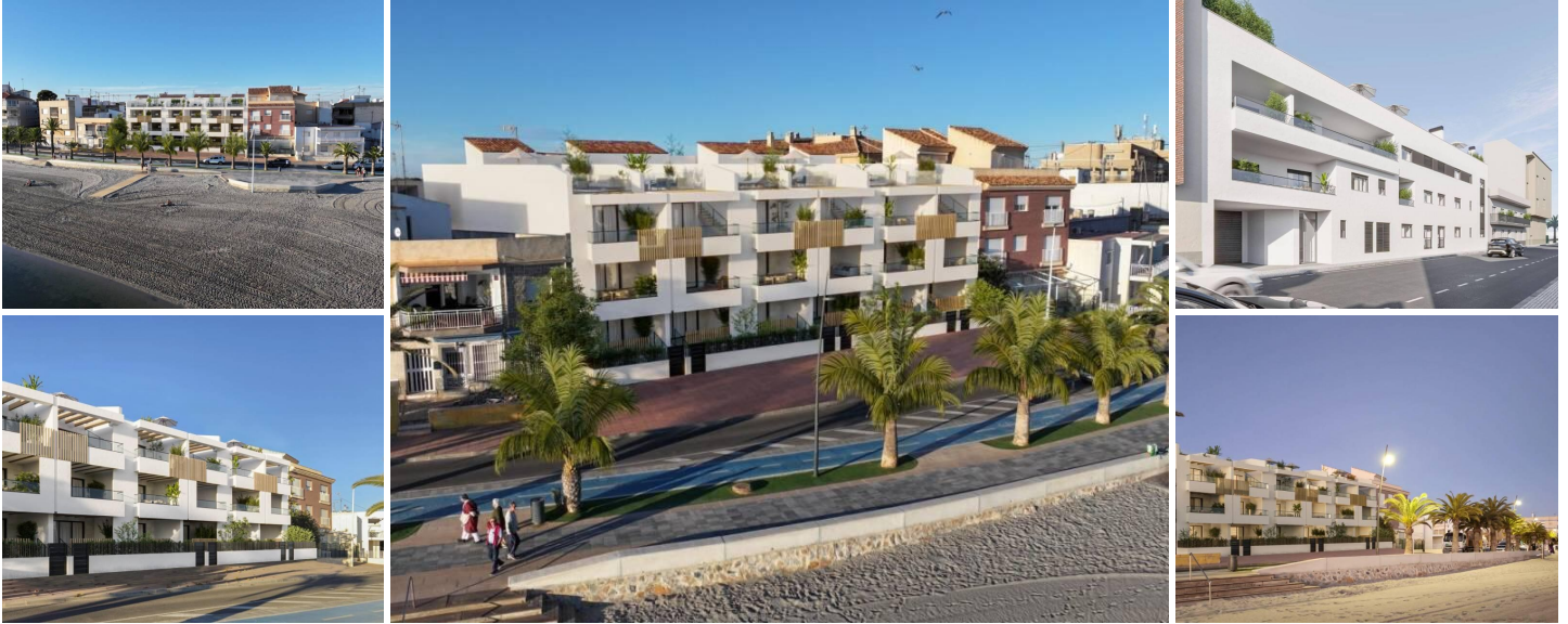
NIEUWBOUW VILLA IN SAN PEDRO DEL PINATAR
