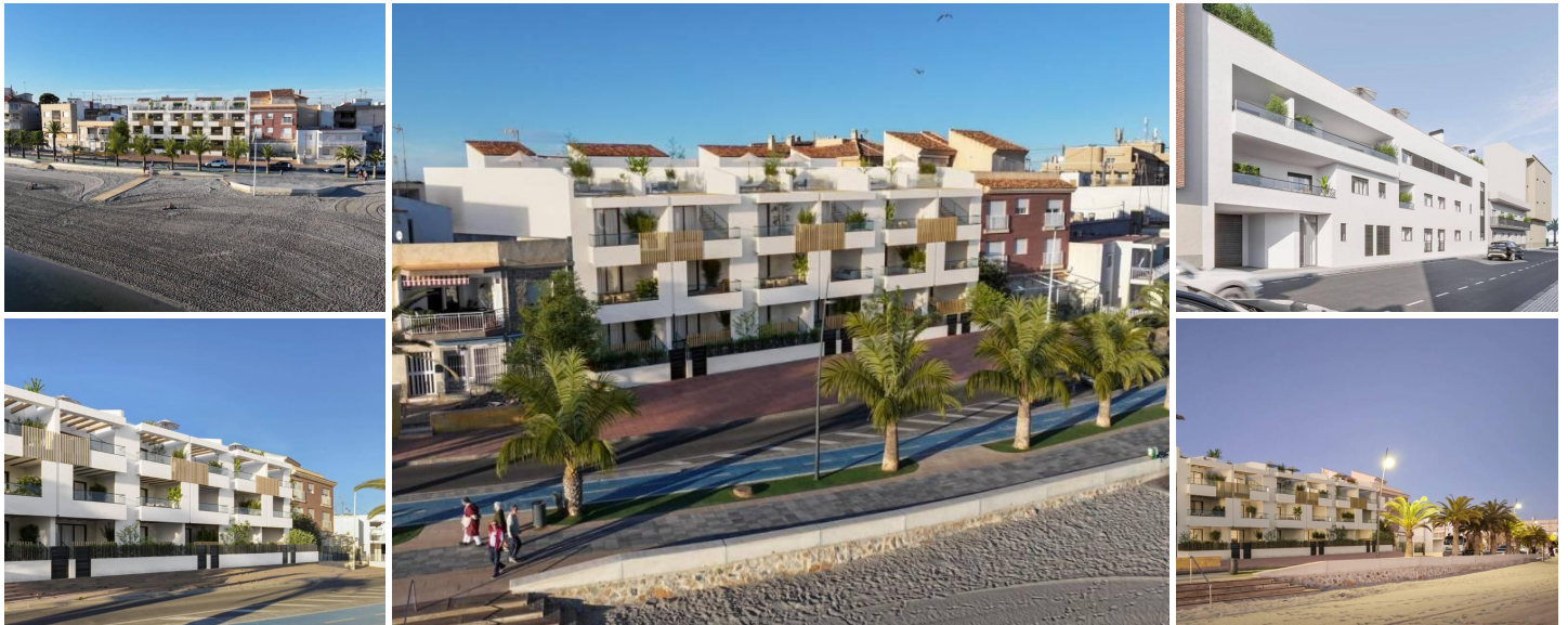
NIEUWBOUW VILLA IN SAN PEDRO DEL PINATAR
