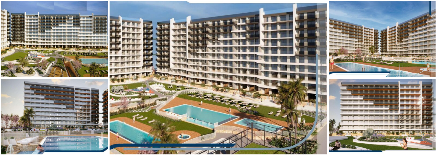
Nieuwbouw wooncomplex in punta prima
