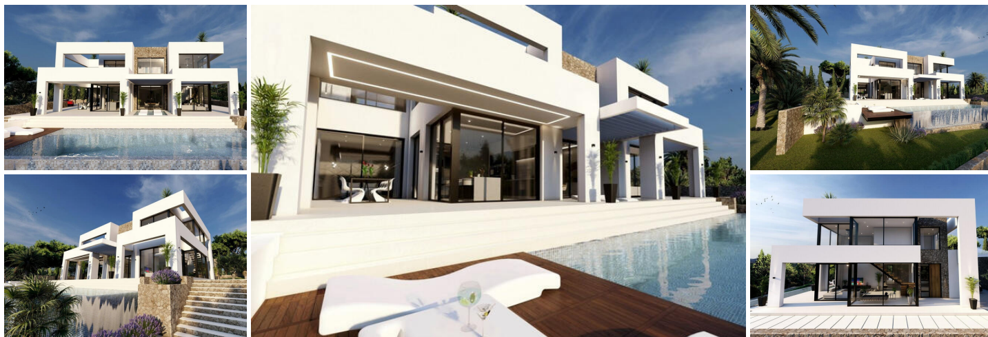
NIEUWBOUW VILLA IN BENNISA
