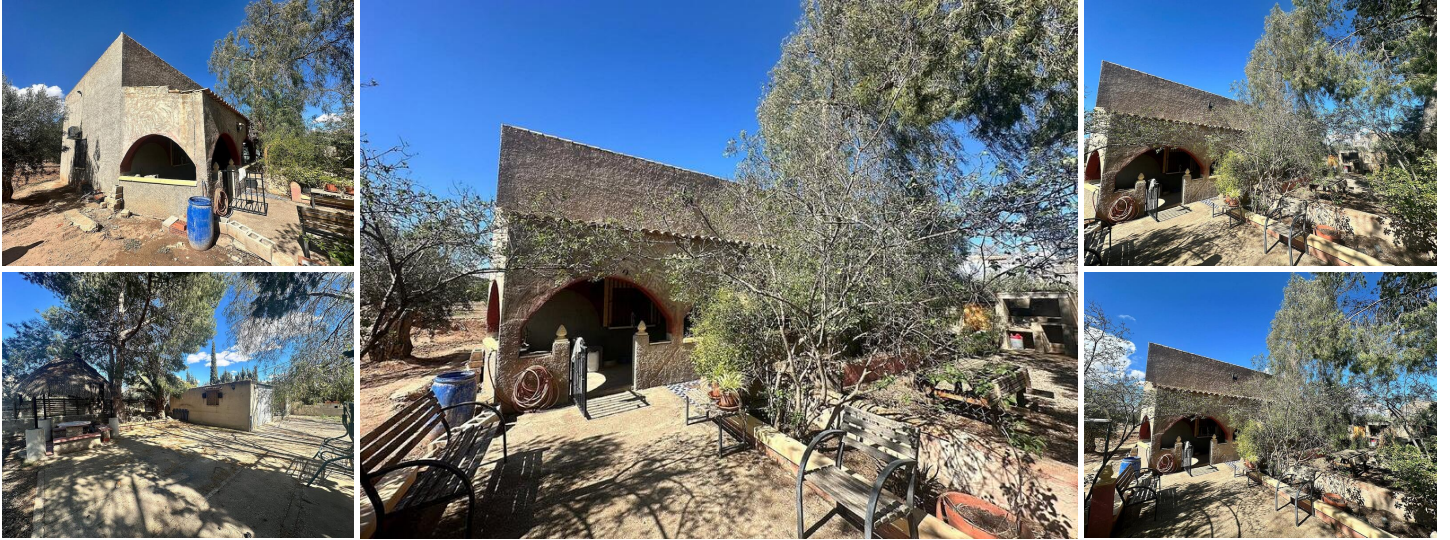
Landhuis om te renoveren in Jumilla.
