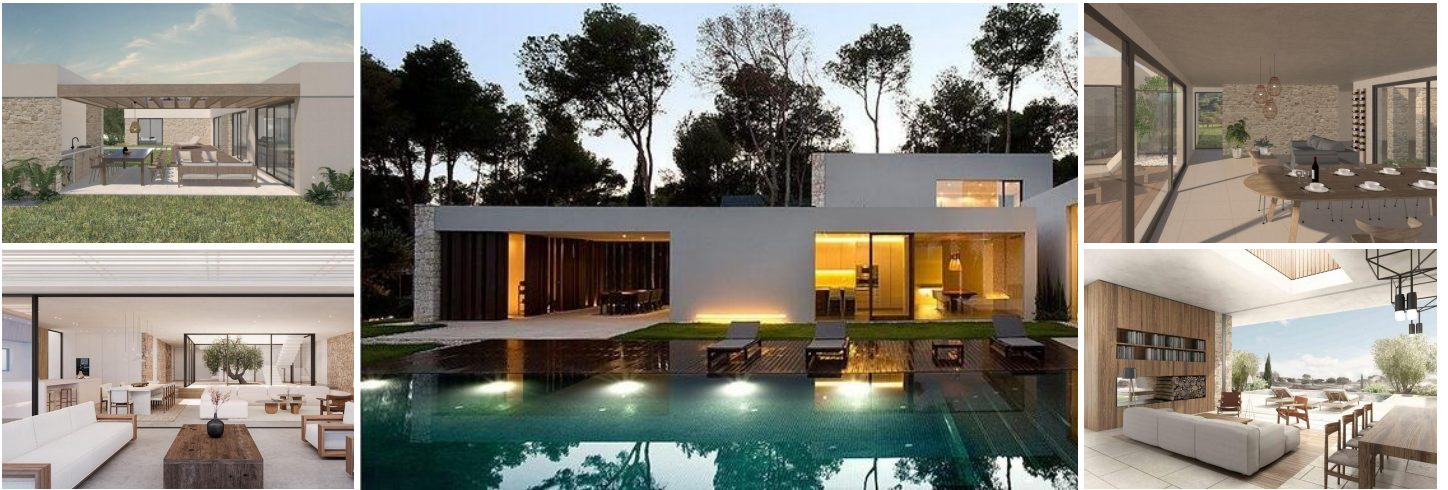
NIEUWBOUW VILLA IN YECLA, MURCIA
