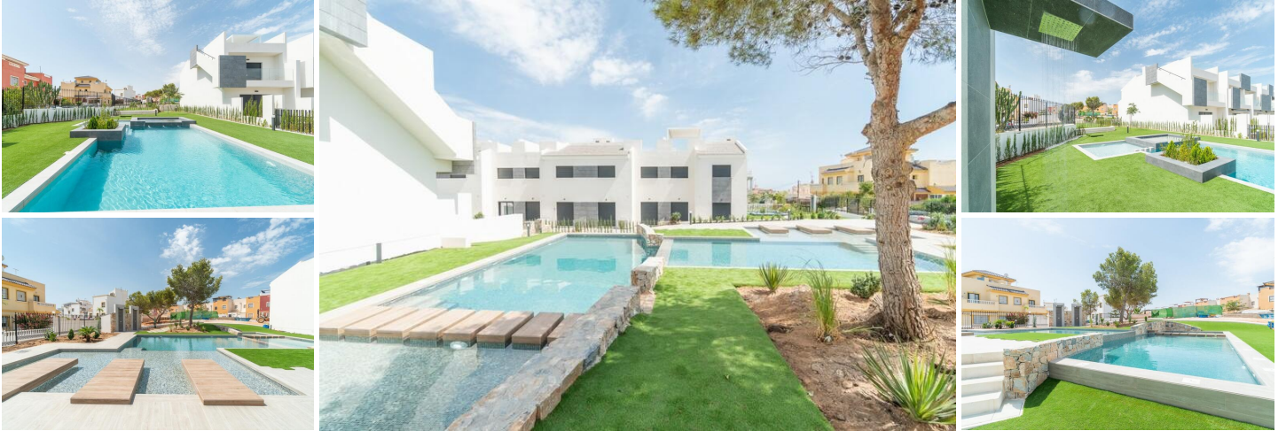
Nieuw wooncomplex in Los Balcones (Torrevieja)
