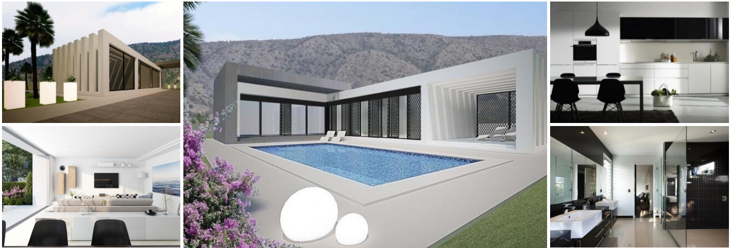
NIEUWBOUW VILLA IN PINOSO
