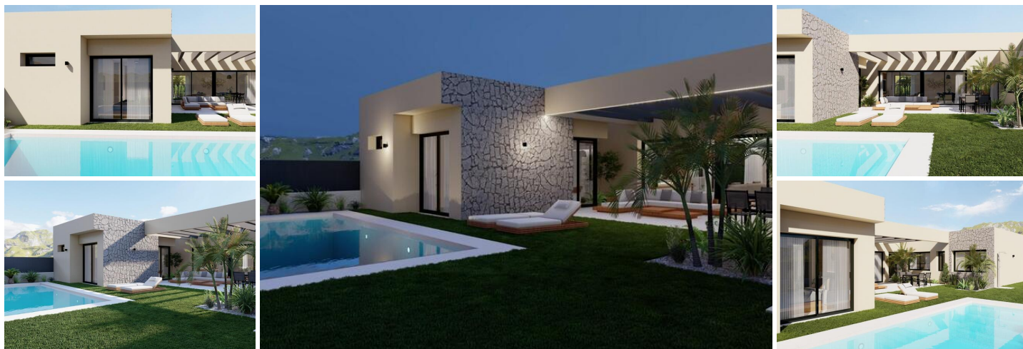
NIEUWBOUW VILLA'S IN ALTAONA GOLF RESORT, MURCIA
