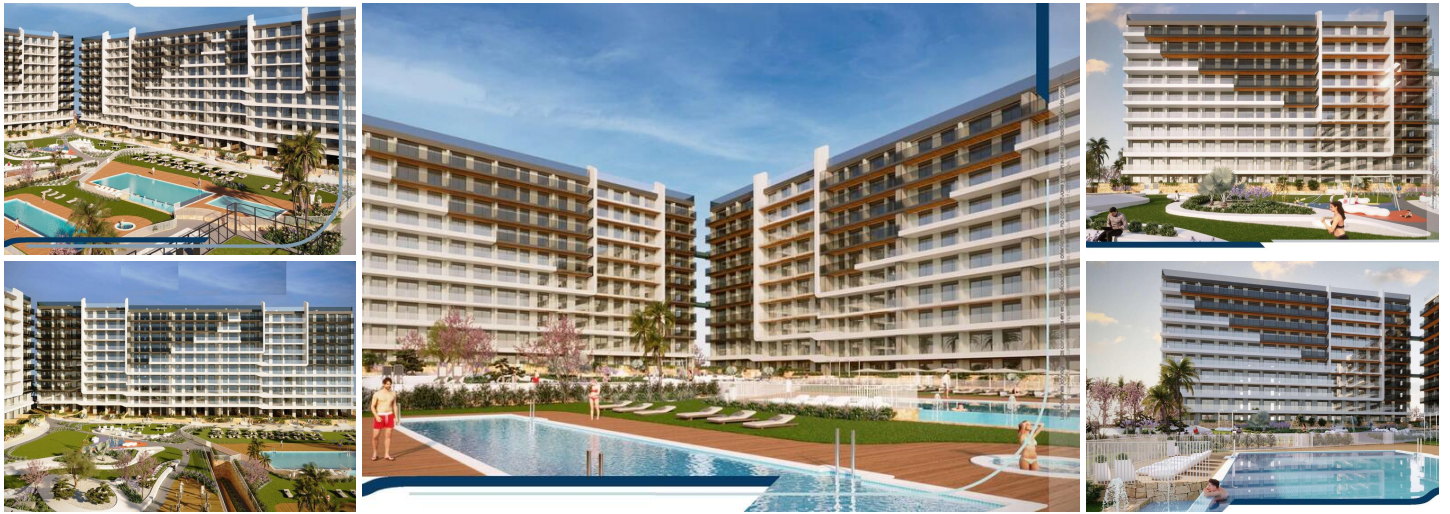
NIEUWBOUW WOONCOMPLEX IN PUNTA PRIMA
