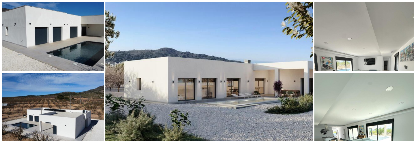
Villas neuves a pinoso
