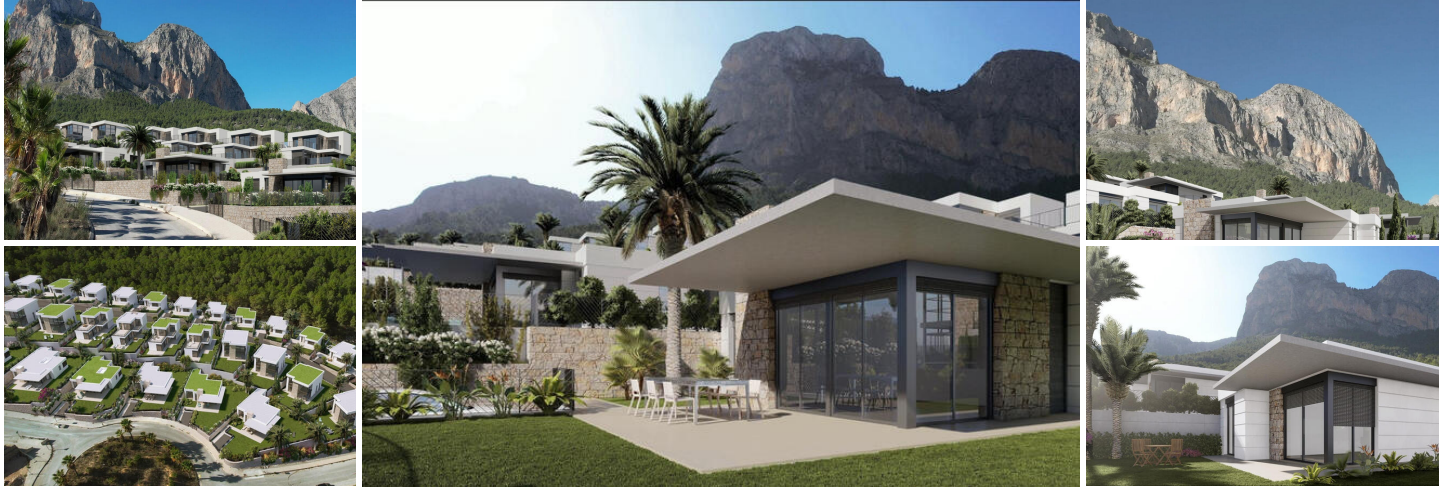
Villas neuves à Polop, Alicante
