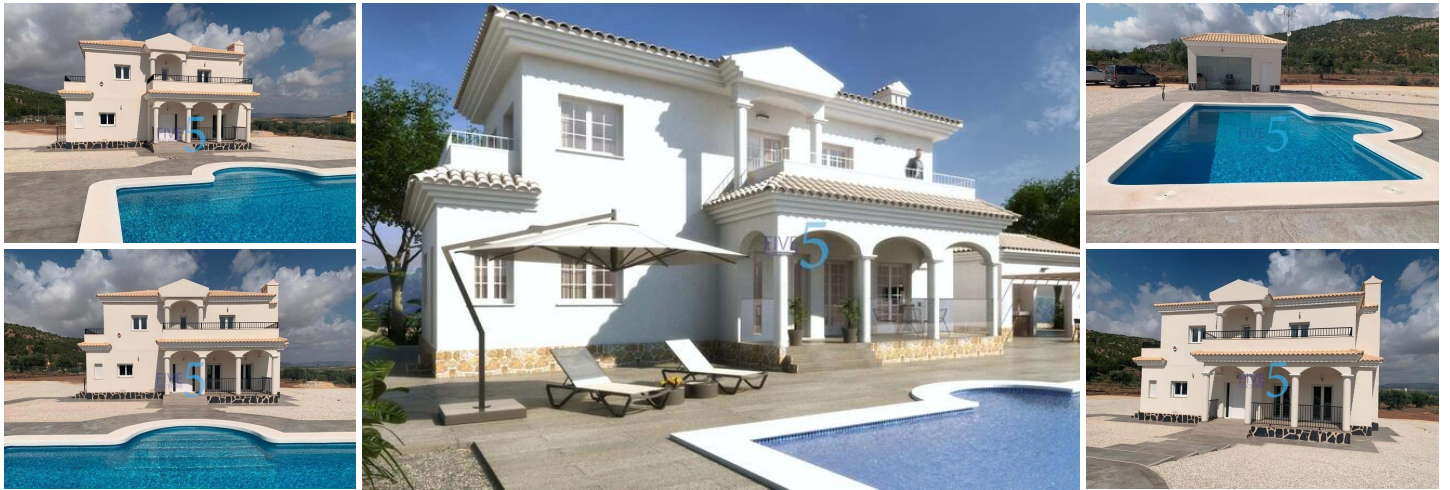
VILLAS NEUVES A PINOSO
