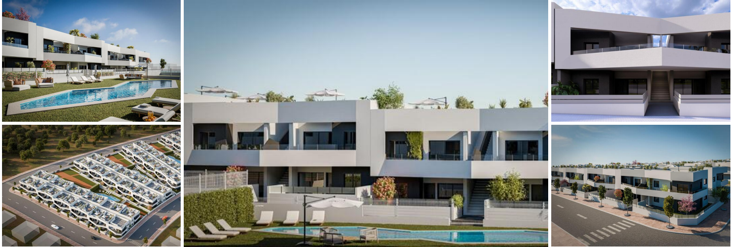
Bungalows Modernos de Obra Nueva en San Miguel de Salinas con 3 Piscinas Comunitarias
