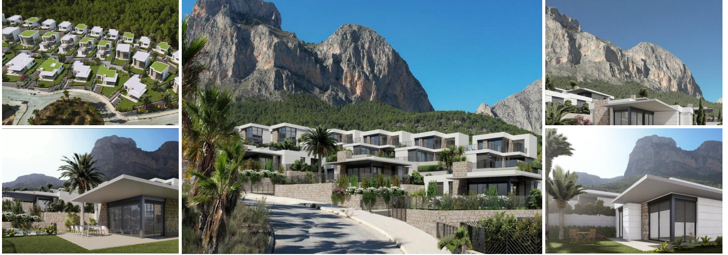
Chalets de Nueva Construcción en Polop, Alicante
