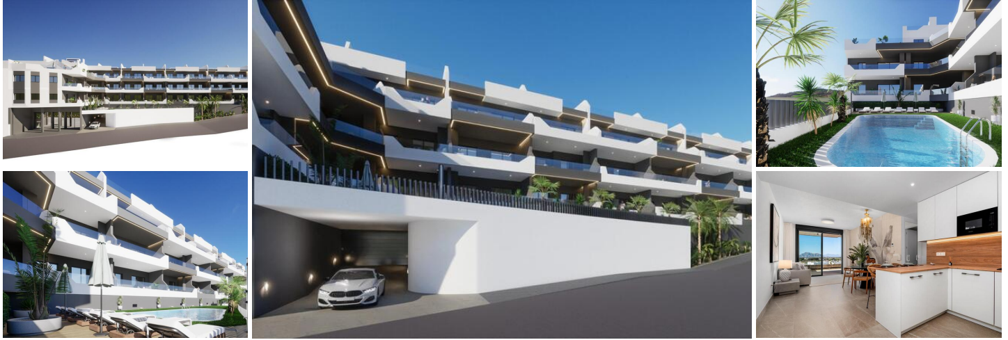
COMPLEJO RESIDENCIAL DE OBRA NUEVA EN BENIJOFAR
