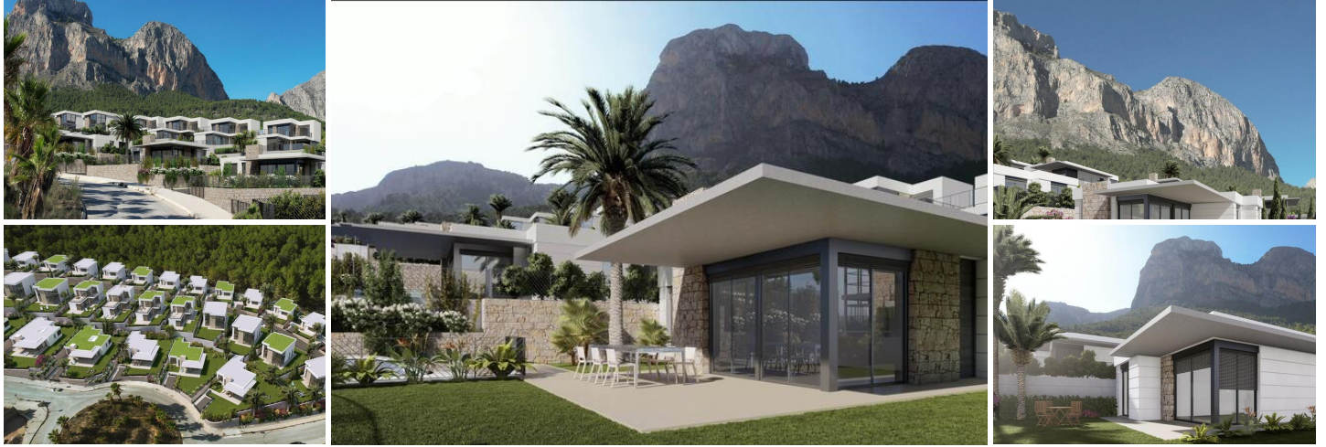
Chalets de Nueva Construcción en Polop, Alicante
