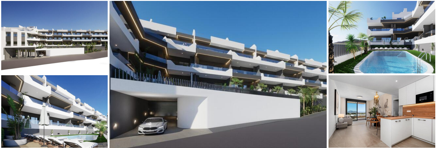
COMPLEJO RESIDENCIAL DE OBRA NUEVA EN BENIJOFAR
