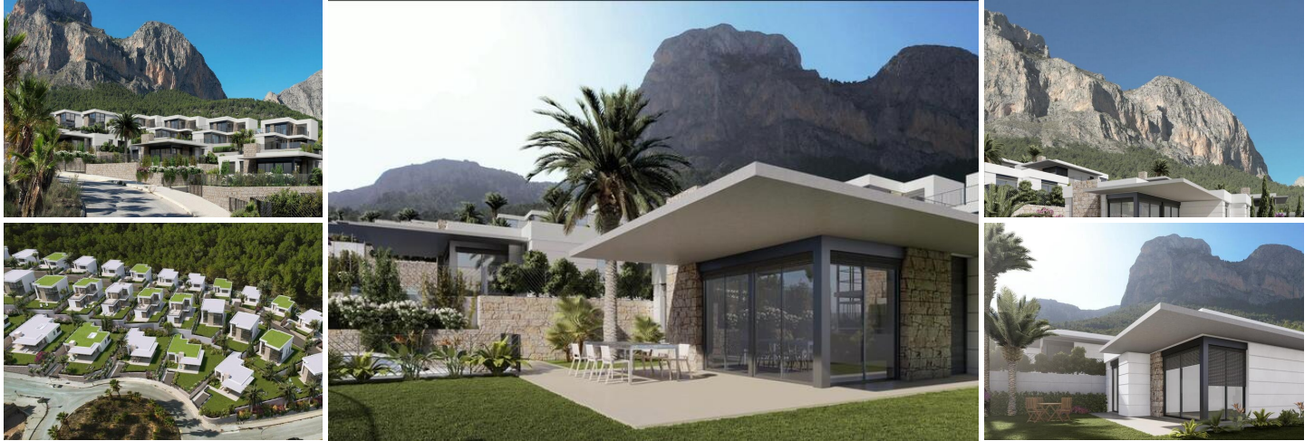
Chalets de Nueva Construcción en Polop, Alicante
