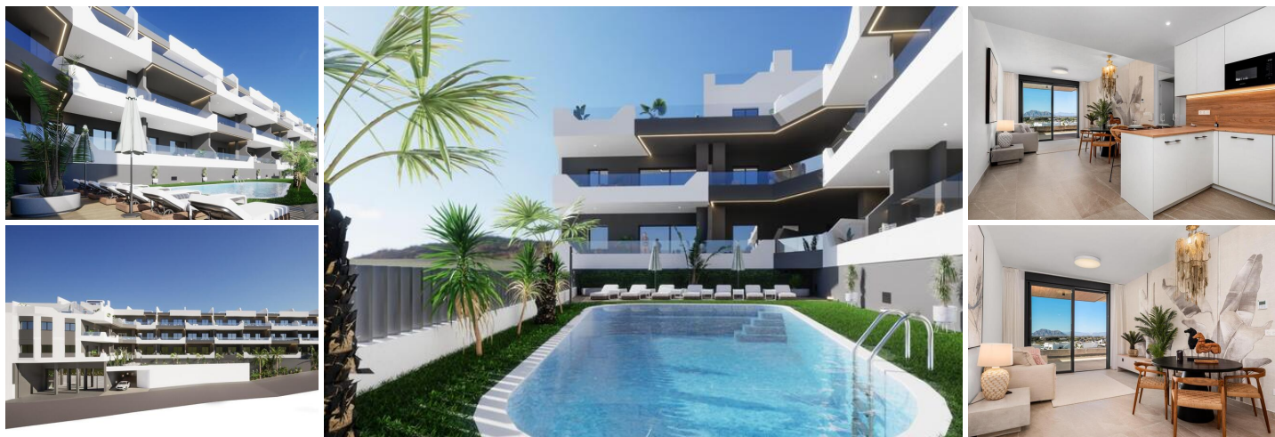
COMPLEJO RESIDENCIAL DE OBRA NUEVA EN BENIJOFAR
