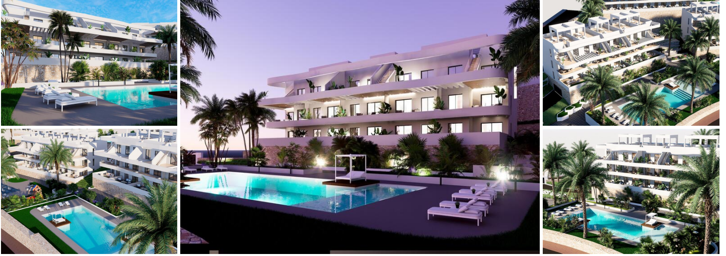
COMPLEJO RESIDENCIAL DE OBRA NUEVA EN FINESTRAT
