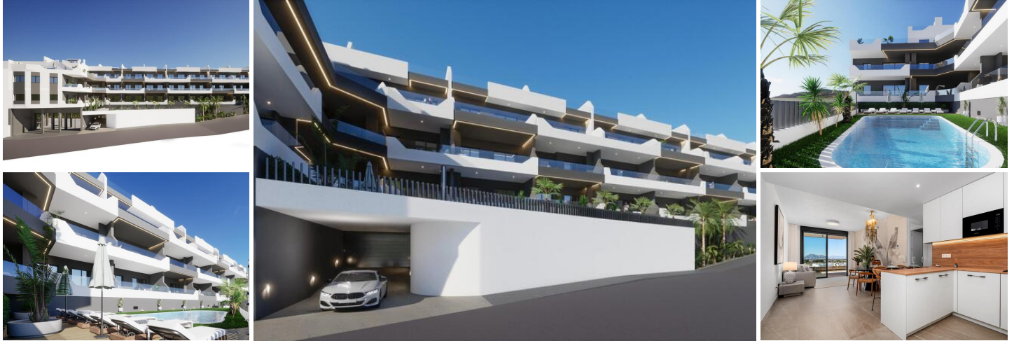
COMPLEJO RESIDENCIAL DE OBRA NUEVA EN BENIJOFAR
