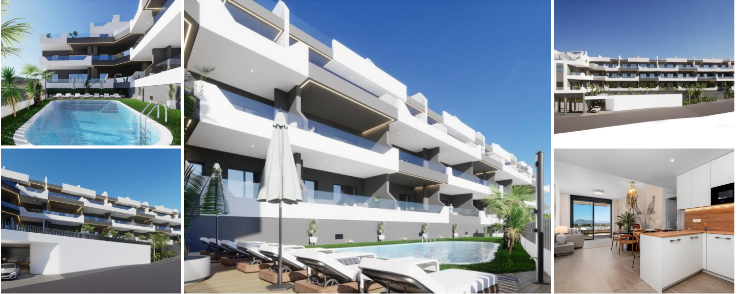
COMPLEJO RESIDENCIAL DE OBRA NUEVA EN BENIJOFAR
