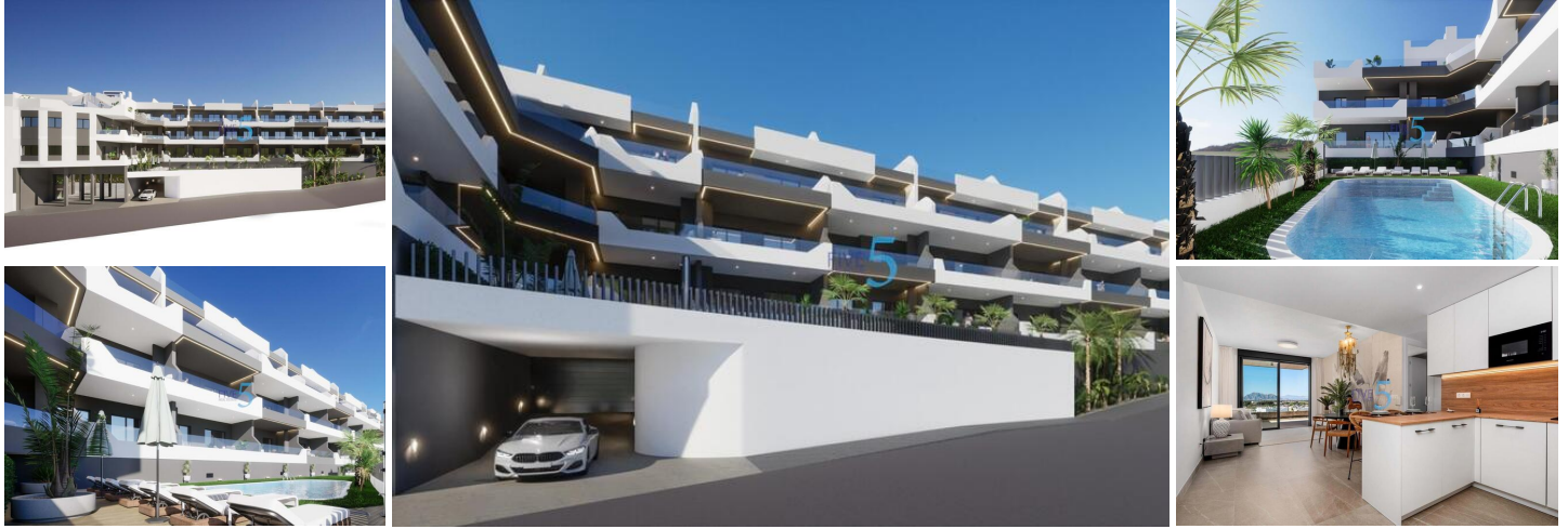
COMPLEJO RESIDENCIAL DE OBRA NUEVA EN BENIJOFAR
