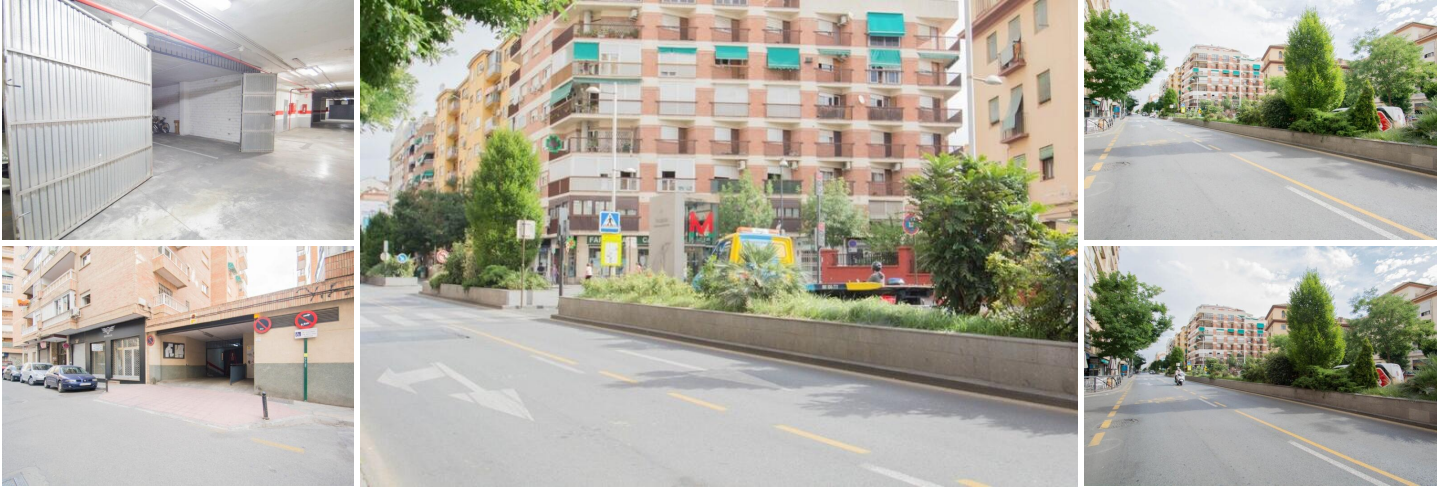
Plaza de garaje cerrada con portón compartido. Acceso peatonal por montacargas o ascensor. Fácil maniobra.
