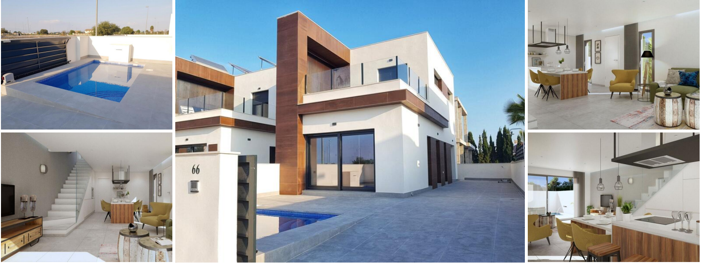
PAREADOS DE OBRA NUEVA EN DAYA NUEVA
