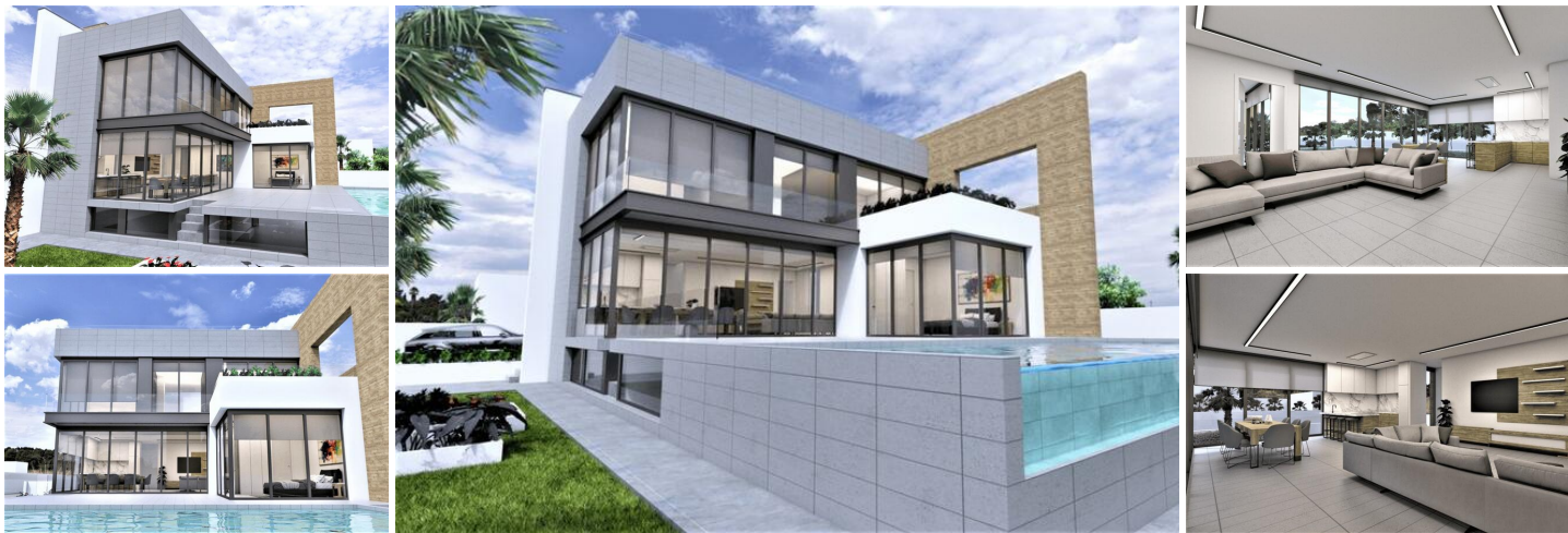
VILLA DE LUJO DE OBRA NUEVA CERCA DE LA PLAYA DE LA ZENIA
