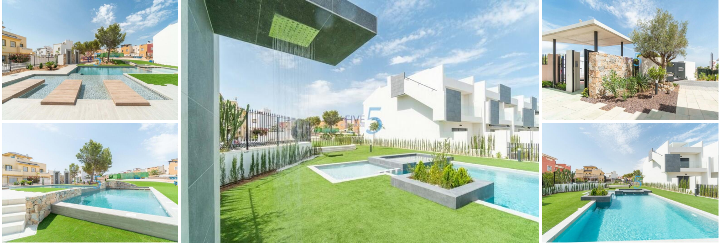
Nuevo conjunto residencial en Los Balcones (Torrevieja)
