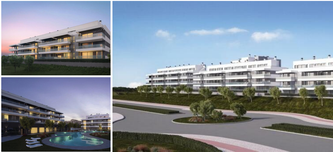
Apartamento de 2 dormitorios en La Cala de Mijas
