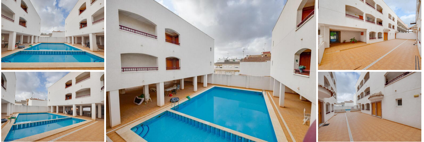
Renovierte Apartments im Zentrum von San Fulgencio
