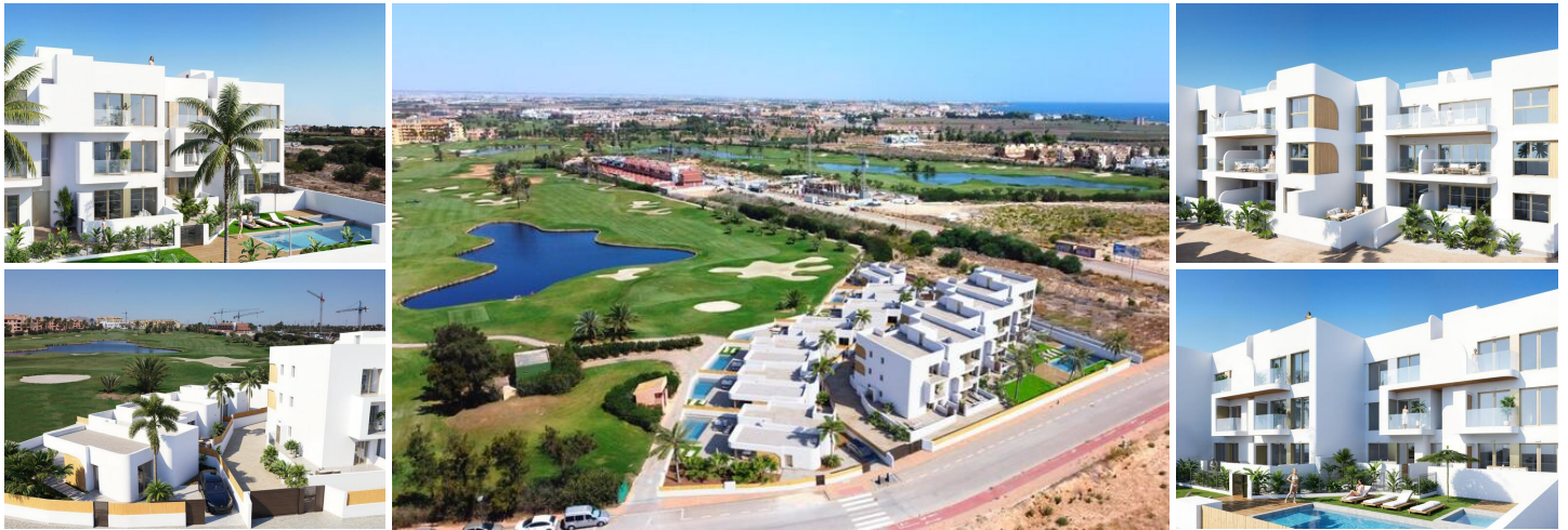
Neubau-Wohnkomplex in Los Alcázares an der Frontline von Serena Golf
