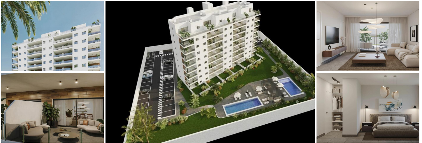
Neubauwohnungen in Cala Finestrat, Villajoyosa
