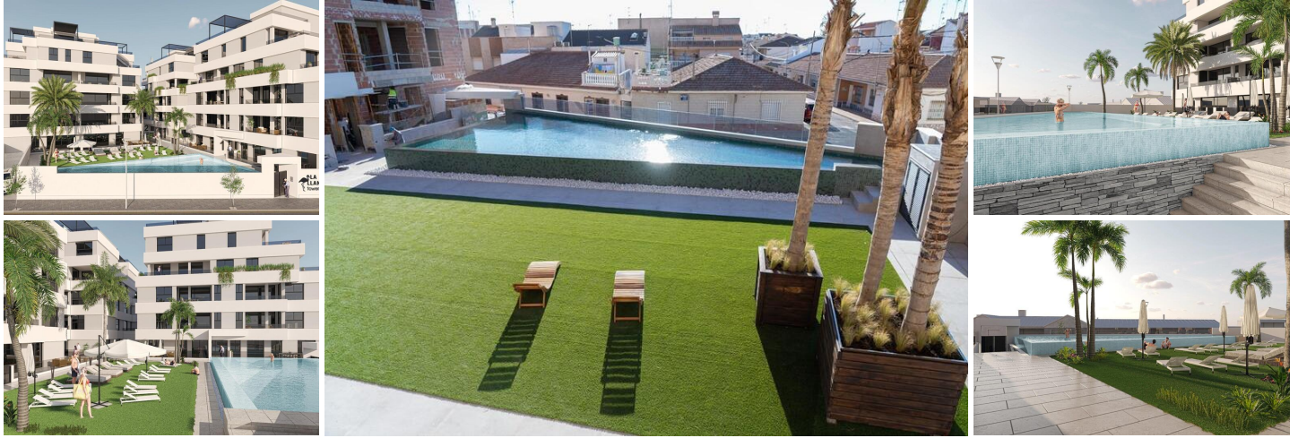
NEUBAU WOHNANLAGE IN SAN PEDRO DEL PINATAR
