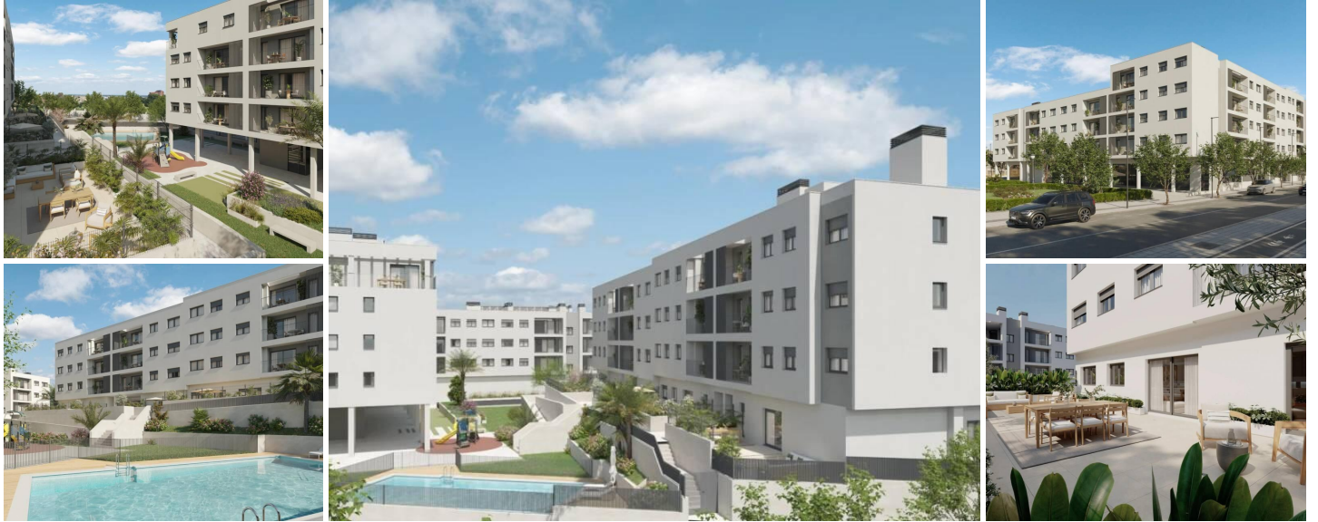
Neue Wohnsiedlung in Alicante mit offenem Blick
