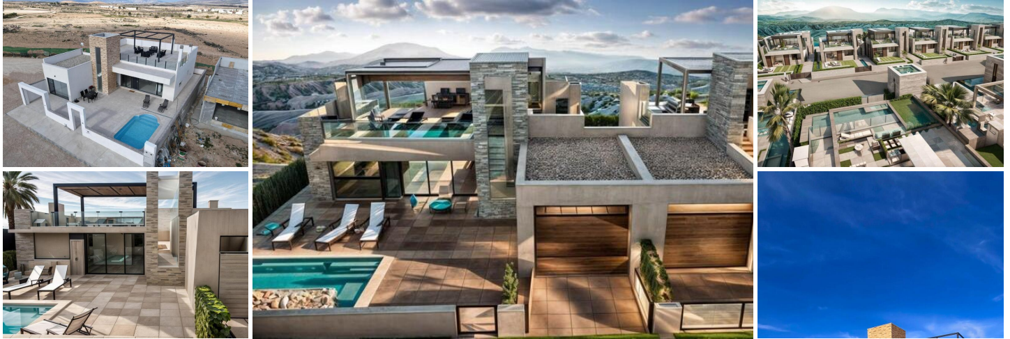
NEU GEBaute VILLEN IN FUENTE ALAMO, MURCIA
