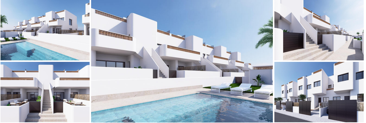
Neubau Bungalows in Dolores
