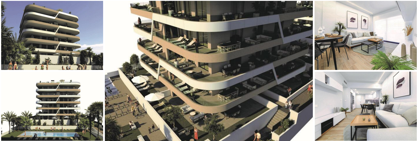
NEUBAU WOHNANLAGE IN ARENALES DEL SOL
