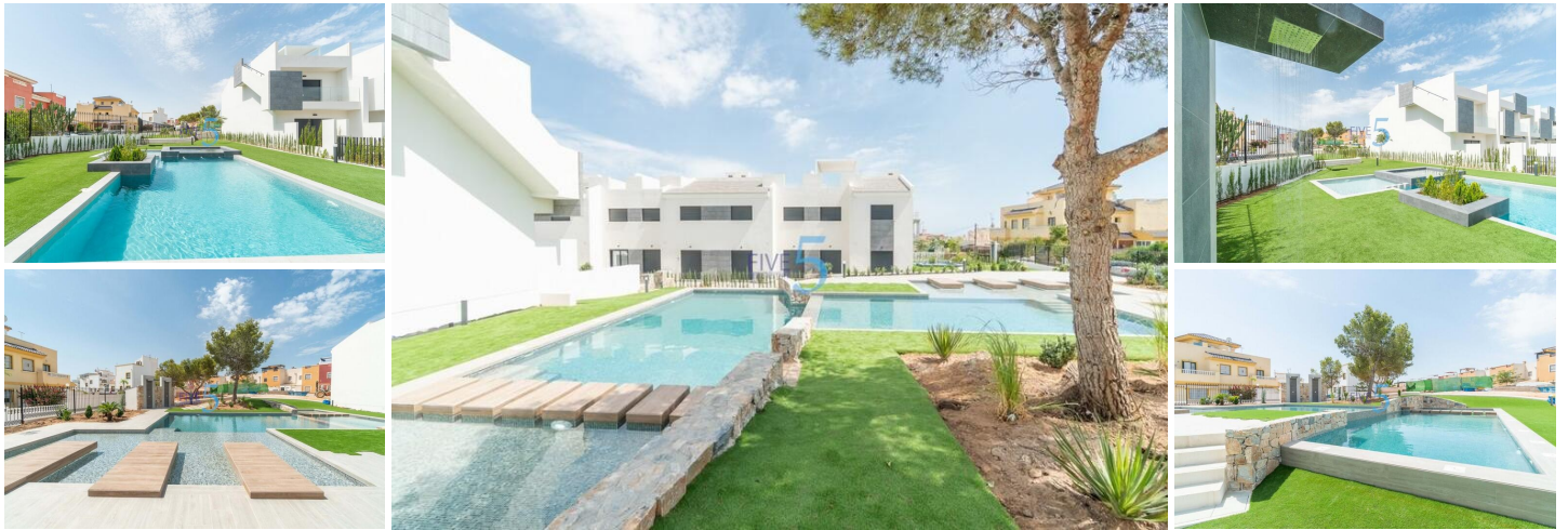
Neue Wohnanlage in Los Balcones(Torrevieja)
