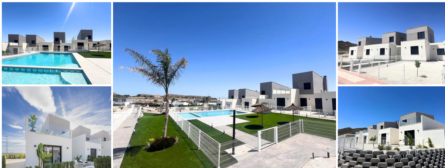
NYBYGGEDE RÆKKEHUSE I ALTAONA GOLF RESORT, MURCIA
